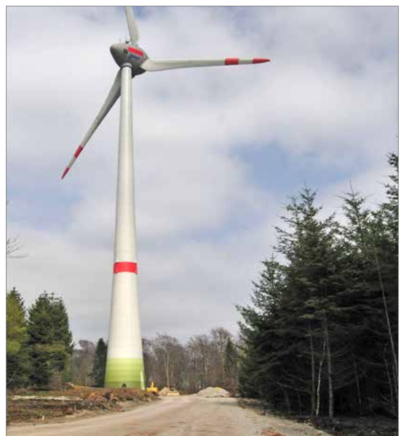
Für 1 Windrad werden 15.000 m 2 Wald gerodet und 6-8 m breite Zuwege + Kabeltrassen gebaut!
