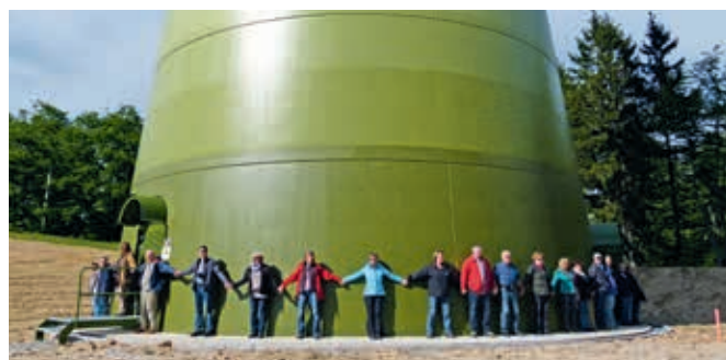
Der monströse Fuß von einer Windindustrieanlage!
